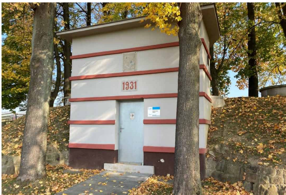
Vodojem Alžbětinky v Jablunkově. | Foto: se svolením SmVak
