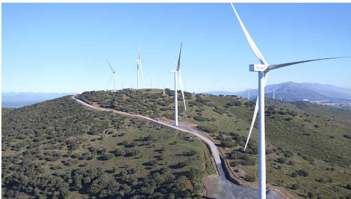
Parque eólico Merengue (Extremadura).
